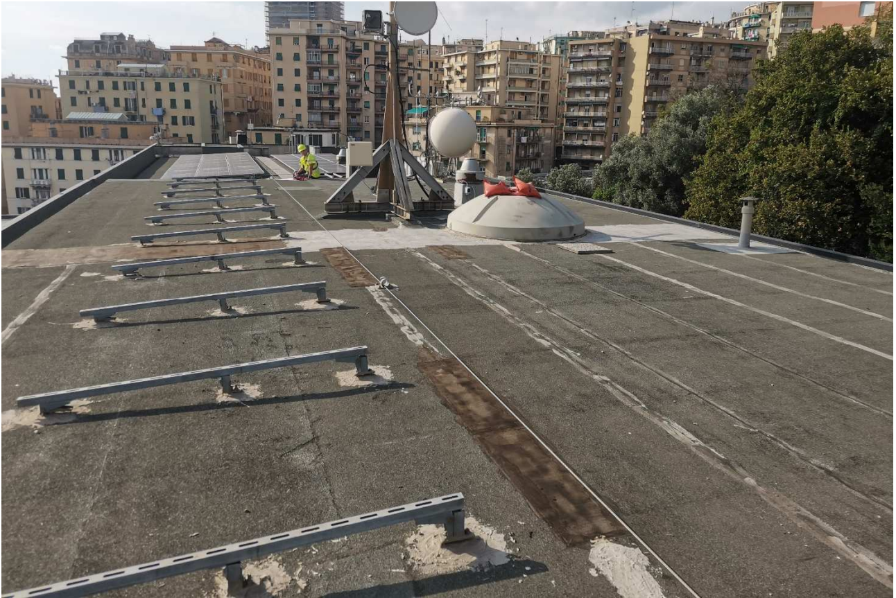
Figura 14: Punto di ripresa fotografica 66 – Vista Copertura del corpo principale (immagine realizzata precedentemente all'inizio delle lavorazioni di manutenzione provvisoria dell'impermeabilizzazione in essere al momento)
