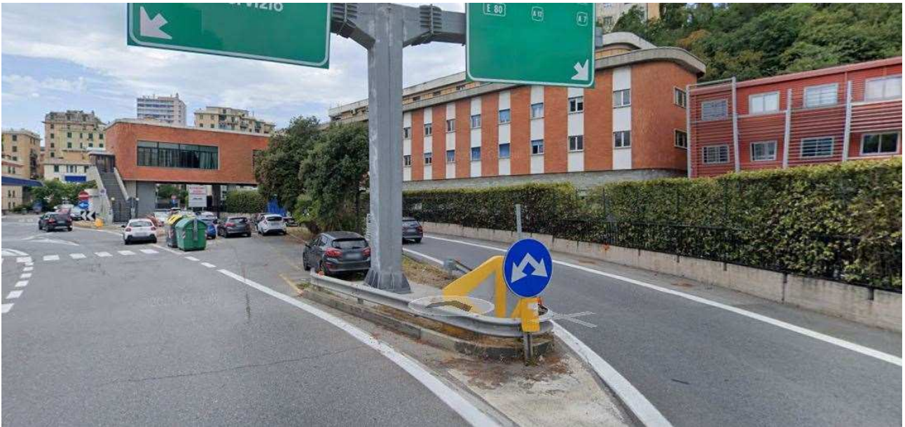
Figura 1: Punto ripresa fotografica 48: Visione totale del fabbricato fronte sud-est dalla viabilità stradale
