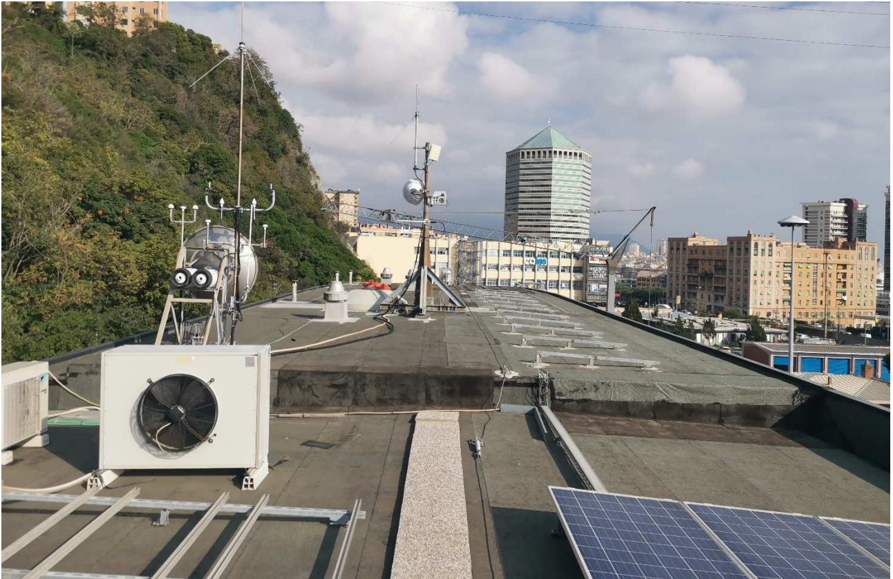
Figura 13: Punto di ripresa fotografica 65 – Vista Copertura del corpo principale (immagine realizzata precedentemente all'inizio delle lavorazioni di manutenzione provvisoria dell'impermeabilizzazione in essere al momento)
