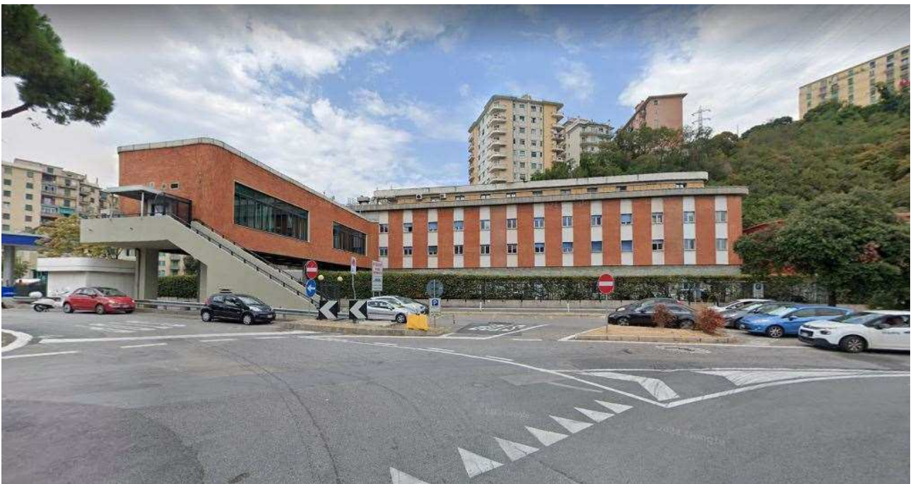
Figura 2: Punto ripresa fotografica 49 – Visione totale del fabbricato fronte sud dalla viabilità stradale (immagine realizzata precedentemente all'inizio delle lavorazioni sul corpo a ponte – non oggetto del presente appalto - il quale attualmente risulta coperto da ponteggi)
