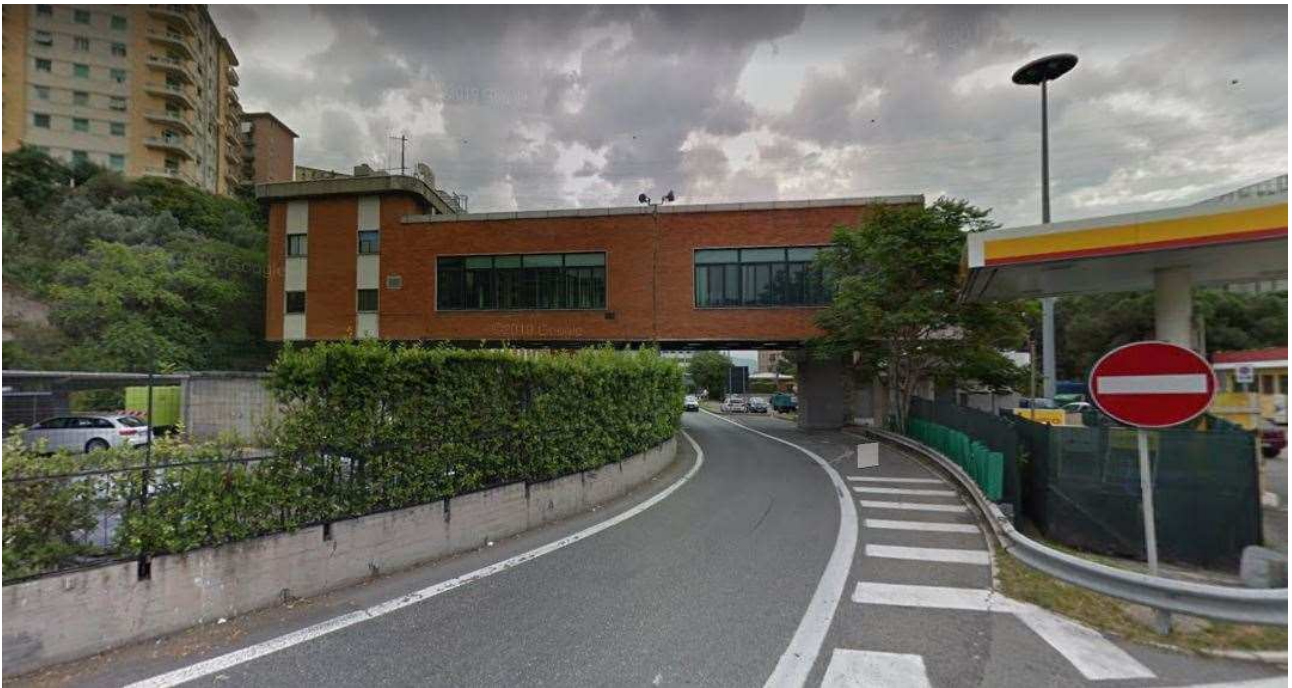
Figura 3: Punto di ripresa fotografica 50 – Visione totale del fronte ovest del fabbricato principale e del corpo ponte (immagine realizzata precedentemente all'inizio delle lavorazioni sul corpo a ponte – non oggetto del presente appalto - il quale attualmente risulta coperto da ponteggi)
