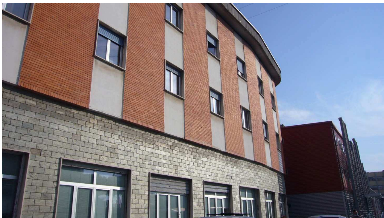
Figura 10: Punto di ripresa fotografica 62 – Vista generale prospetto sud verso est con tutti gli elementi di alterazione dei progetti 1969-1973
