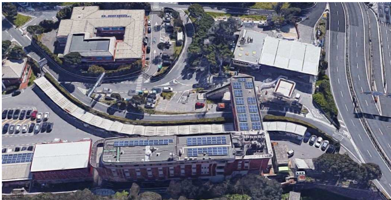
Figura 7: Punto di ripresa fotografica 54 – Visione aerea del fronte nord del fabbricato principale e del corpo a ponte
